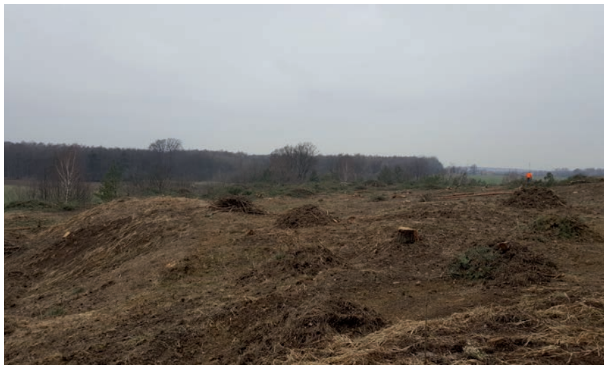
Usuwanie materii organicznej zalegającej pod wyciętymi drzewami w Tarnowskich Górach (Fot. MJK)
